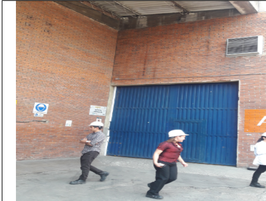
Foto 1: Fachada e Ingreso Bodega de Almacenamiento
